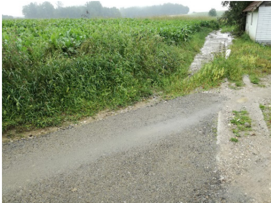
Abbildung 1: Der Graben vor dem Haus wurde zur Gänze mit Schotter und Erde gefüllt.
