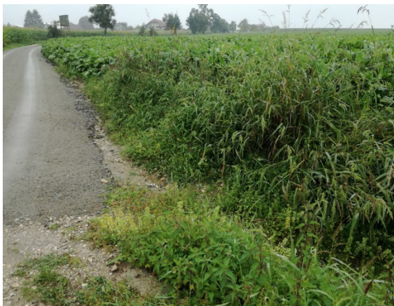
Abbildung 3: Die Gemeindestraße wurde neu asphaltiert und die Bankette als Graben zwischen Feld und Straße angelegt.
