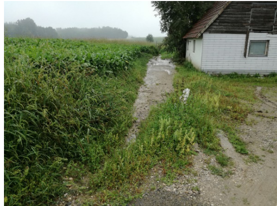
Abbildung 2: Der Graben konnte kein Wasser mehr ableiten und das Erosionsmaterial wurde in die Einfahrt des Hauses transportiert.
