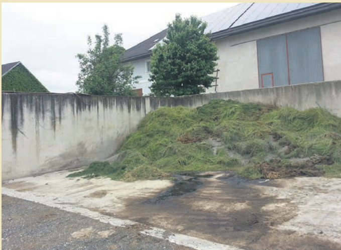
Sickersäfte müssen unbedingt in einer dichten Gülle- bzw. Jauchegrube gesammelt werden.
