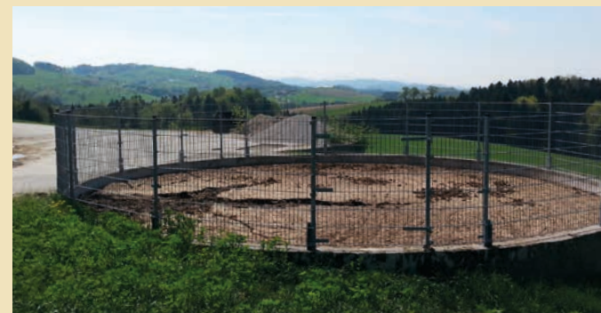
Offene Güllegruben müssen bei Betrieben ab ca. 20 GVE bis Ende 2027 abgedeckt werden. BWSB/HÖLZL
