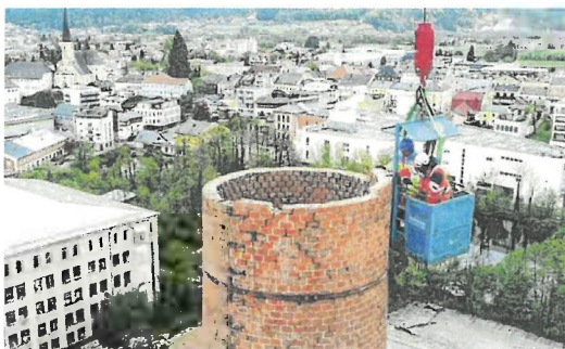
Abbrucharbeiten am Vogl-Schlot
