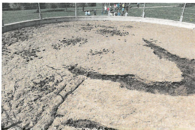
Bereits errichtete offene Güllegruben müssen nicht abgedeckt werden, wenn eine dauerhaft stabile Schwimmdecke vorhanden ist. BWSB/Wallner
