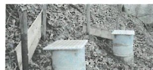
Bretter schützen die Schachtquelle vor Hangwasser.
