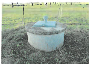
Erhöhter Brunnenschacht mit leicht ansteigendem Gelände.
