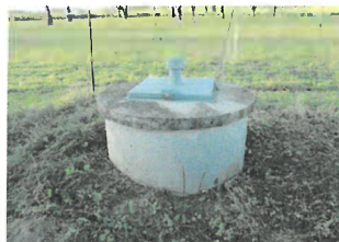
Erhöhter Brunnenschacht mit leicht ansteigendem Gelände.
