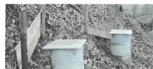
Bretter schützen die Schachtquelle vor Hangwasser.
